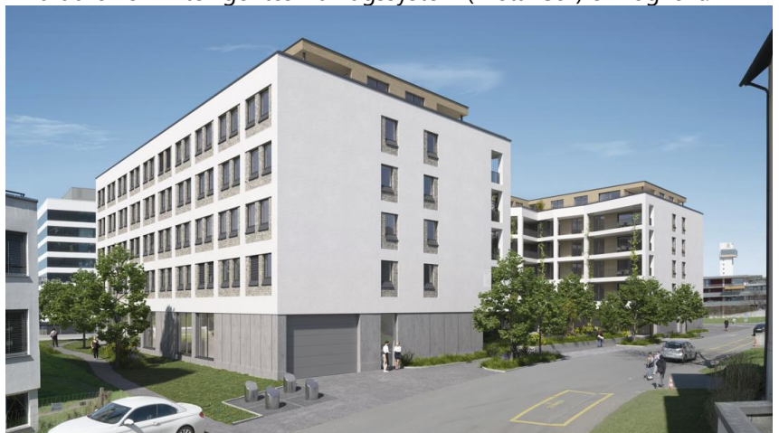
Abbildung 2: Ansicht auf der Zugstrasse, Niederberger Architekten AG
